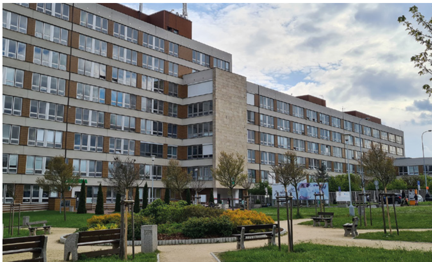
Pavilon F Fakultní nemocnice Plzeň-Lochtín, kde jsou v 7. a 8. patře ambulance jednotlivých oddělení Stomatologické kliniky a v 6. patře je lůžkové oddělení.
