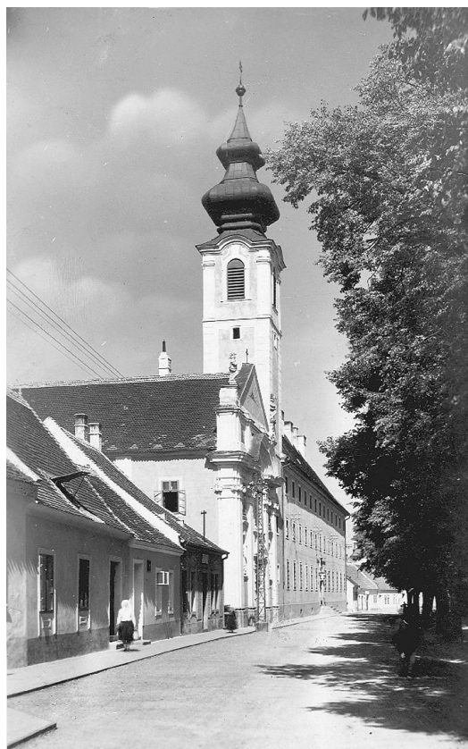
Obr. 1. Kostel a konvent Milosrdných bratří ve Skalici na dobové fotografii (zdroj: www.skalice.sk )
