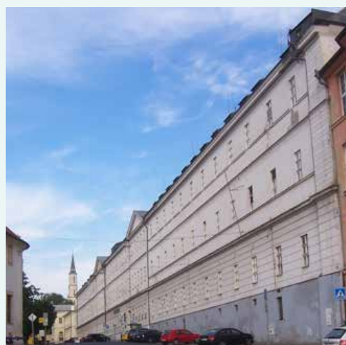
Obr. 12. U nemocnice 499/2 – Všeobecná nemocnice (1790–dosud)
