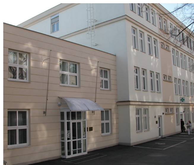
Foto 1 Přístavba LOEC umožnila rozšíření klinických i výukových prostor oční kliniky FNKV a 3.LF UK Praha
