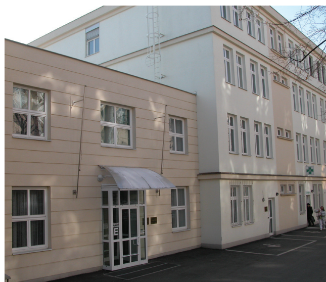
Foto 1 Přístavba LOEC umožnila rozšíření klinických i výukových prostor oční kliniky FNKV a 3.LF UK Praha
