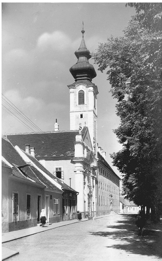
Obr. 1. Kostel a konvent Milosrdných bratří ve Skalici na dobové fotografii (zdroj: www.skalica.sk )
